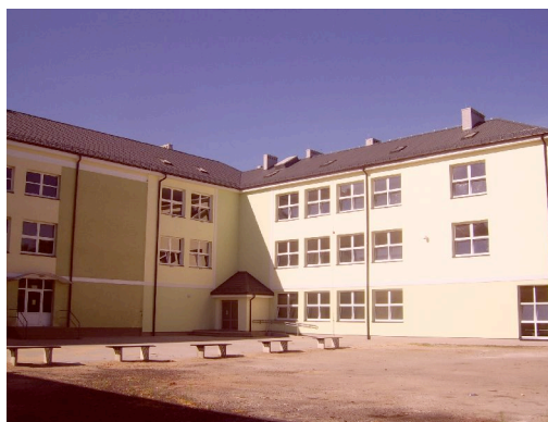
Widok ze strony dziedzińca dobudowanego gimnazjum.
